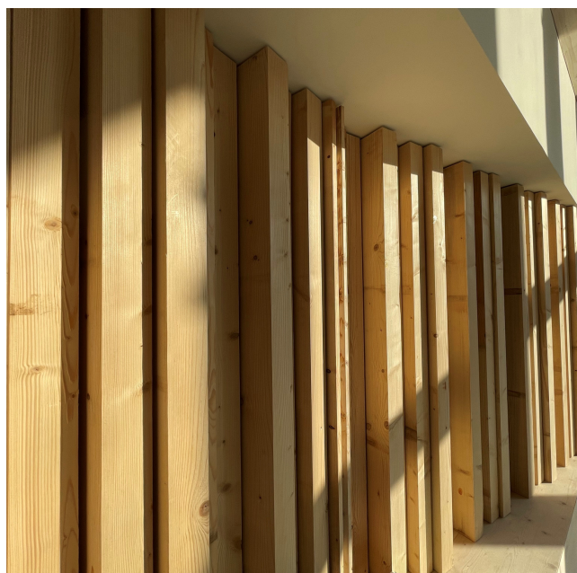
Mur acoustique salle de musique MAC - Crédit photo - service communication
